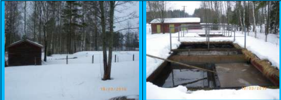
Joonis 7. Veriora aleviku reoveepuhasti BIO 50. Fotod: OÜ Alkranel 19.03.2010.
