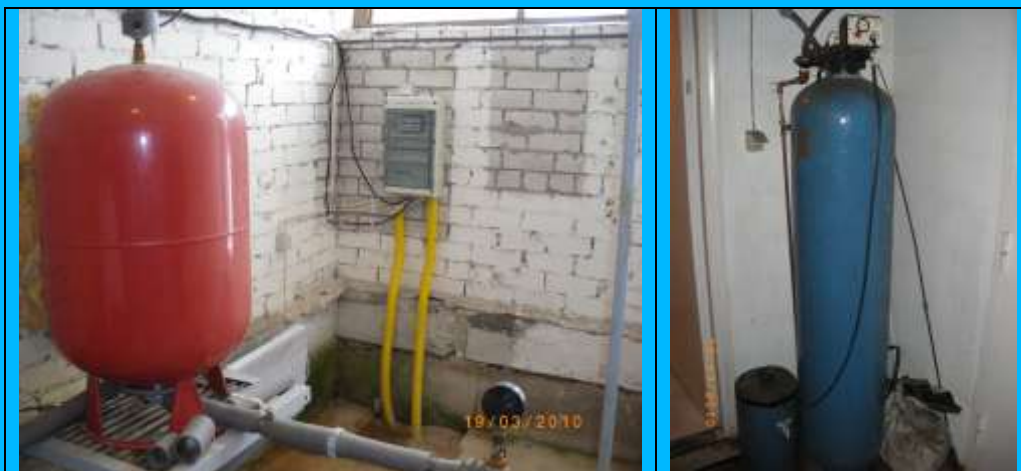
Joonis 10. Viluste Põhikooli puurkaevpumpla. Fotod: OÜ Alkranel 19.03.2010.
